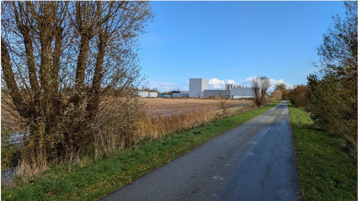
Blick in das Projektgebiet
