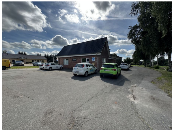
Abb. 4: Blick Richtung Süden auf die vorhandene Zufahrt und die Diakoniestation
