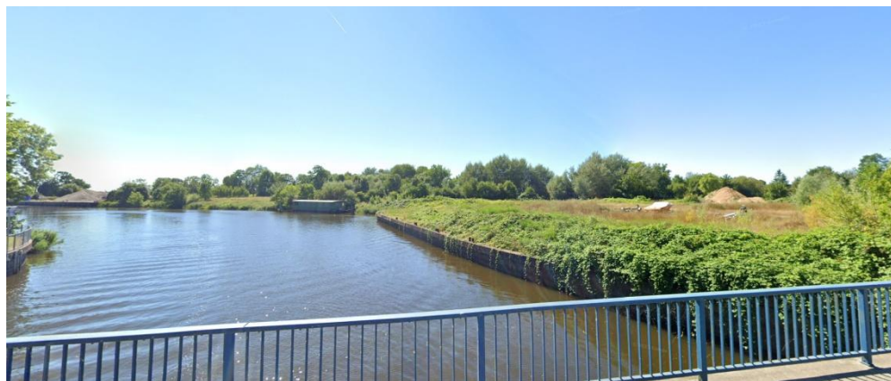
Blick von der Tönninger Straße nach Süden (von der Brücke aus) auf den Neuen Hafen und das rechts angrenzende Plangebiet, Quelle: google streetview
