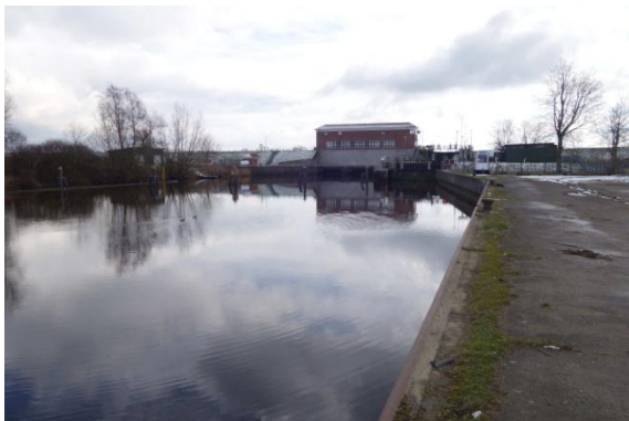
Blick auf die Eiderschleuse im Süden
