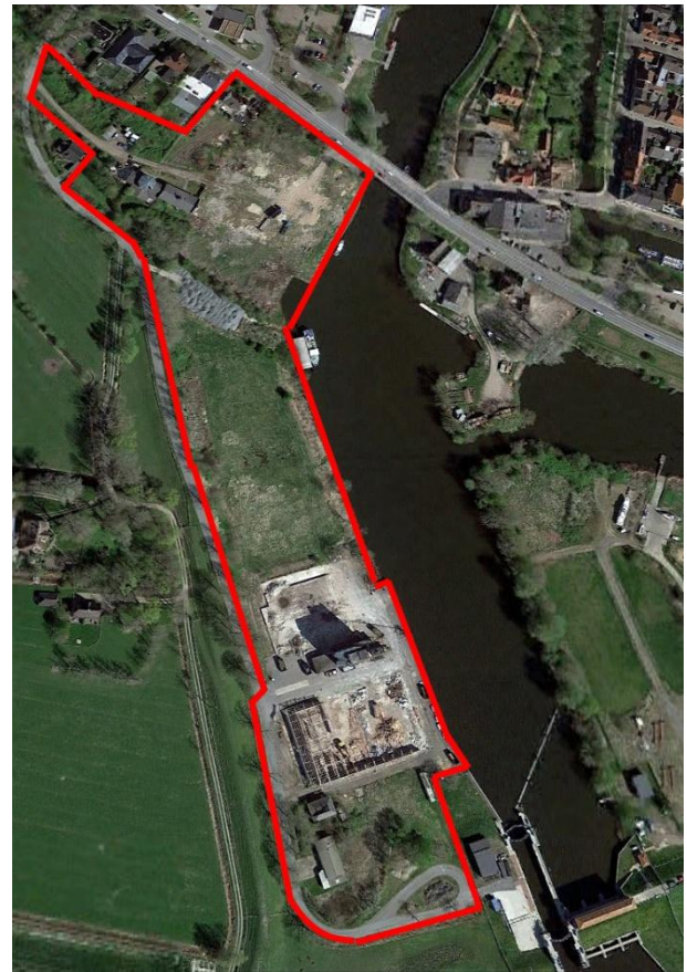
Luftbild ca. 2023, während / nach den Abrissarbeiten, Quelle google maps (ohne Maßstab)
