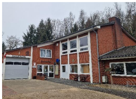
Abb.: Feuerwehr/ Gemeindehaus/ Kita
