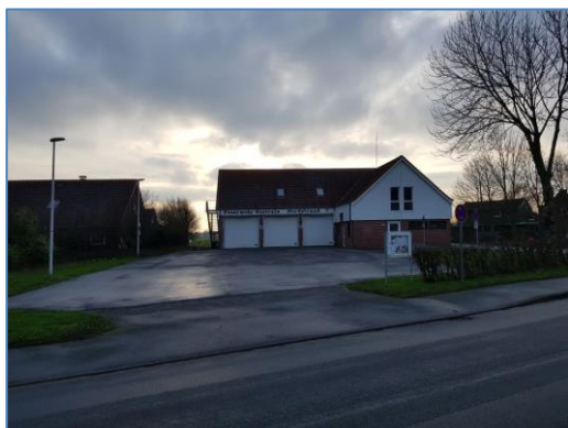
Foto 1: Bestandsgebäude Feuerwehr mit versiegelter Auffahrt, Blick von der Osterkoogstraße
